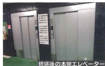
修繕後の本館エレベーター
